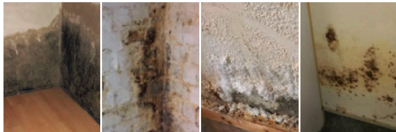
Defekte Horizontalsperre Querdurchfeuchtung Ausblühungen Schimmelbefall
