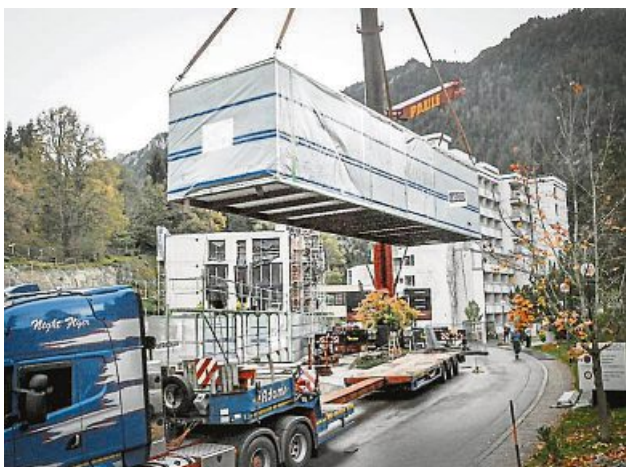
Das Haus Alpspitze wird 2014 in Modultechnik mit 64 containerartigen Teilen neu gebaut.
