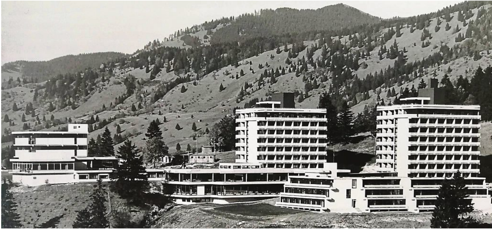
Viel Beton im Alpen-Idyll: Der Neubau der Rheumaklinik ist im Jahr 1971 noch sehr gewöhnungsbedürftig.
